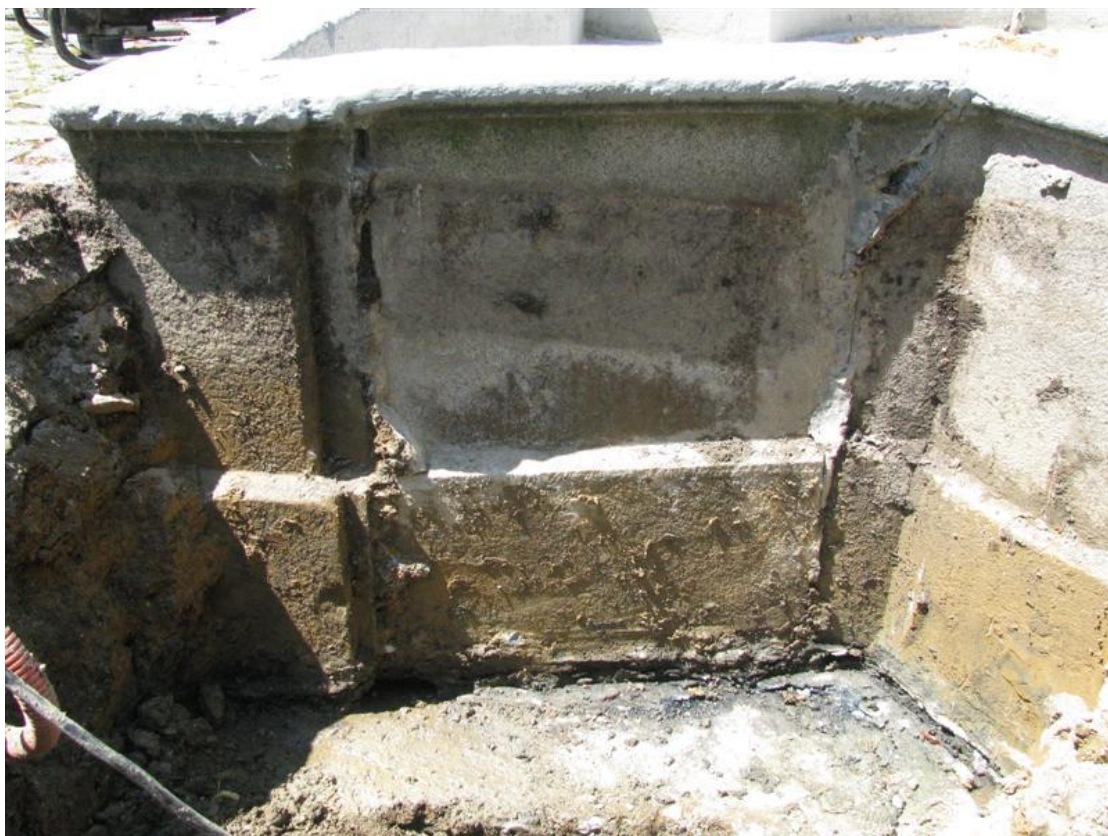
Obrázek 3: Sonda při vnější stěně kašny
