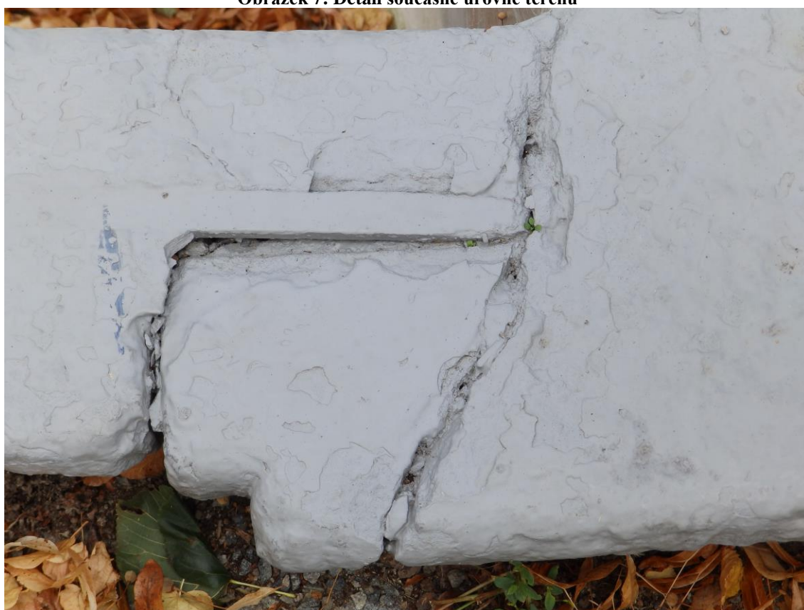
Obrázek 8: Detail poškození spojů
